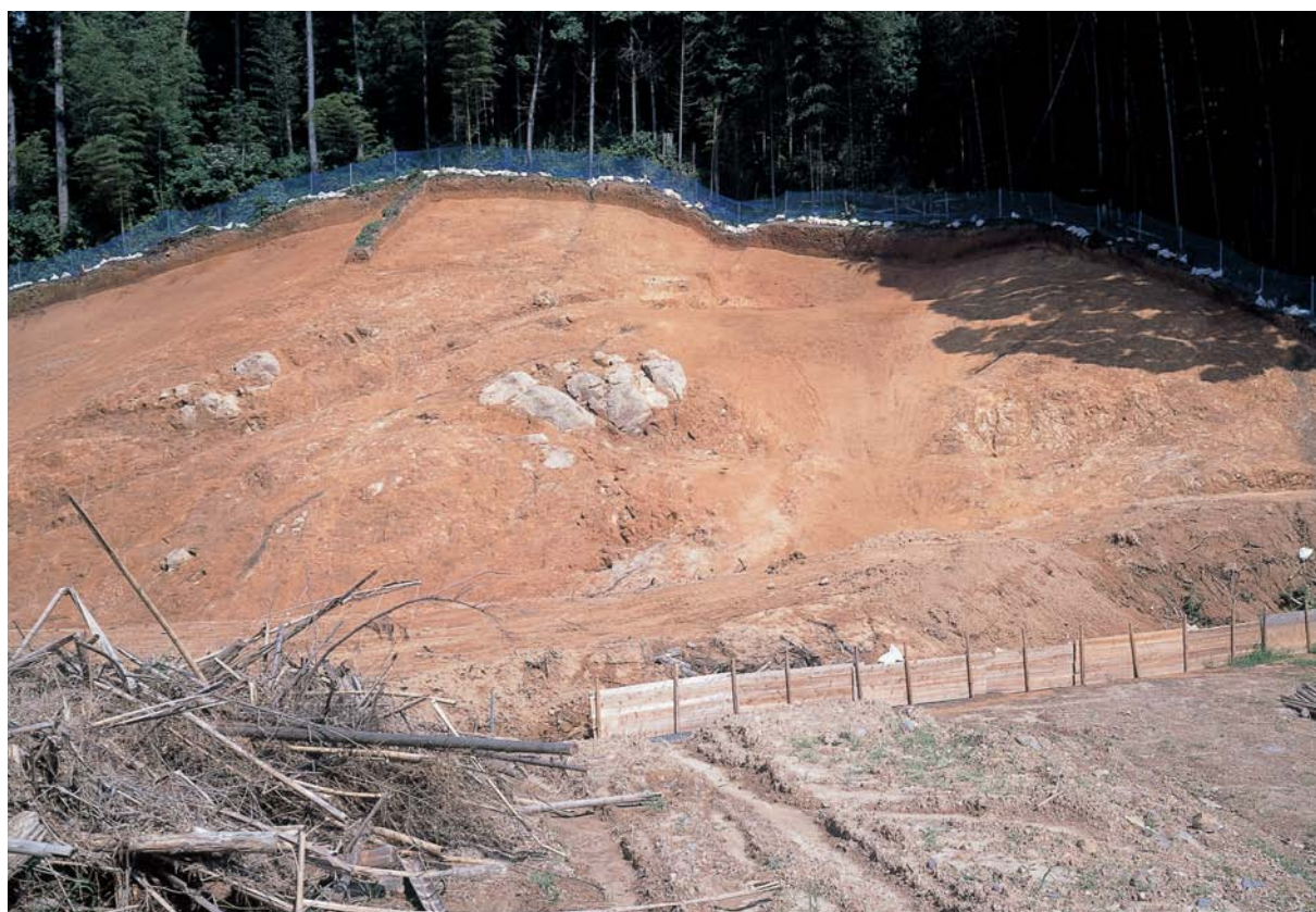
完掘状況(西より)
