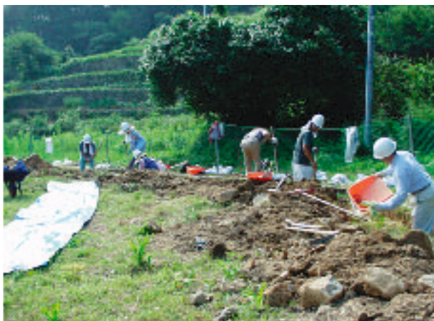
トレンチ掘削状況
